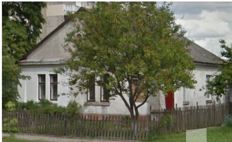
Будинок, 20-ті рр. XX ст., вул. Володимирська, 103;
